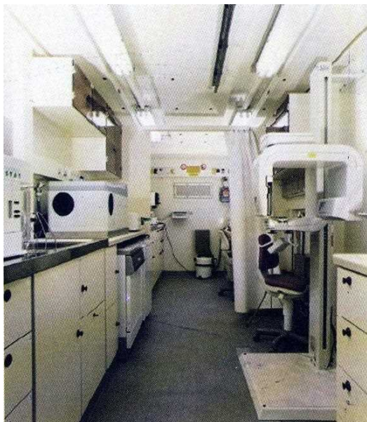
شکل ۲۰-۱ سقف کاذب در یک واحد سیار پزشکی
